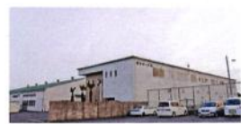
日本ゲージ工場外観
